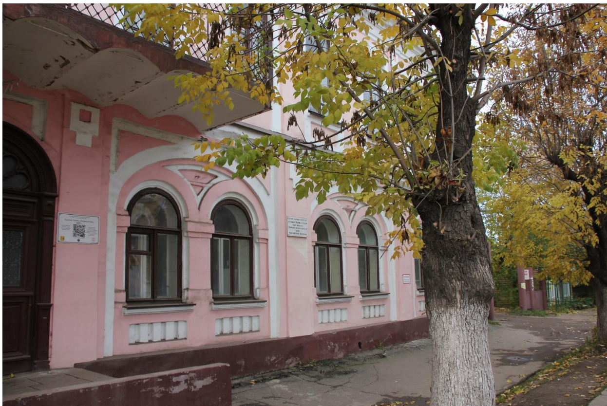
Фото № 2 от 07.10.2016. Фрагмент главного уличного фасада.
