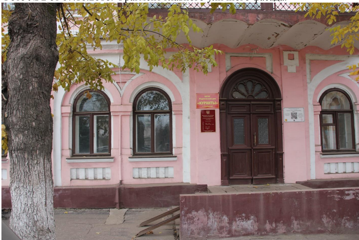
Фото № 3 от 07.10.2016. Фрагмент главного уличного фасада.
